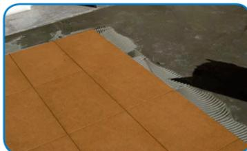
La successiva posa della ceramica, da effettuarsi dopo 7 gg, deve essere eseguita a fuga larga con adesivi di tipo C2 (preferibilmente con classe di deformabilità S1 e S2). La stuccatura va eseguita con malte cementizie sigillanti di classe CG2.
