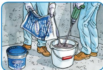
Agitare il componente liquido di **AQUASCUD®** nel suo contenitore e successivamente versarlo in un secchio. Aggiungere gradualmente sotto agitazione il componente polvere di **AQUASCUD®**; effettuare la miscelazione per 3-5 minuti utilizzando un trapano con frusta fino all'ottenimento di un impasto omogeneo e privo di grumi.
