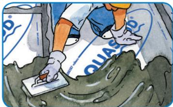
In condizioni climatiche ottimali attendere un periodo di almeno 24 ore per applicare un 2° strato della miscela, avendo cura di ricoprire uniformemente la membrana **AQUASCUD® BASIC**.
