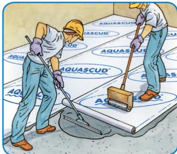
Applicare con apposito frattone dentato Volteco un primo abbondante strato di miscela **AQUASCUD®** in modo da garantire uno spessore minimo di 1÷1,5 mm, facendo in modo che la miscela penetri bene nel sottofondo e copra completamente la superficie.
