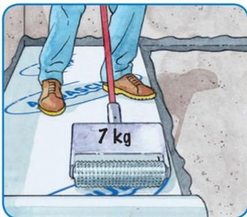
Procedere per settori stendendo immediatamente la membrana **AQUASCUD® BASIC** sulla miscela **AQUASCUD®** ancora fresca, facendola aderire uniformemente al supporto mediante una pressione realizzata con il rullo ad aghi Volteco.
