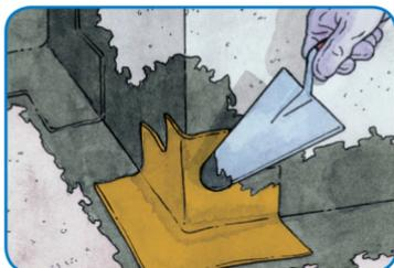
Raccordare gli scarichi, gli spigoli e gli angoli tridimensionali con gli appositi angolari o collettori di scarico preformati utilizzando la miscela **AQUASCUD®** come collante.
